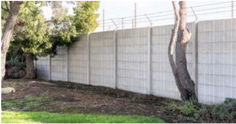
79. attēls. Betona nožogojuma krāsojuma piemērs
